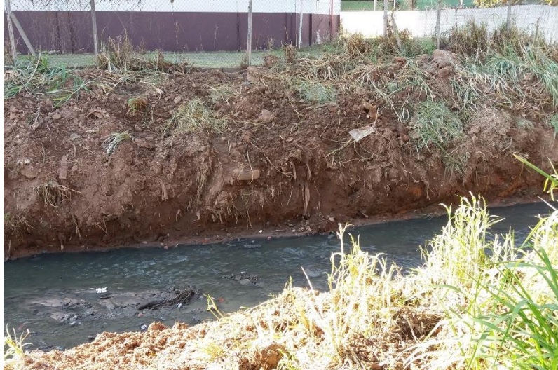
Figura 20 – Vista da Seção 06.1.
