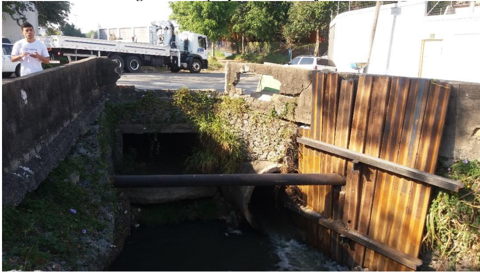
Figura 52 - Seção problemática - jusante.
