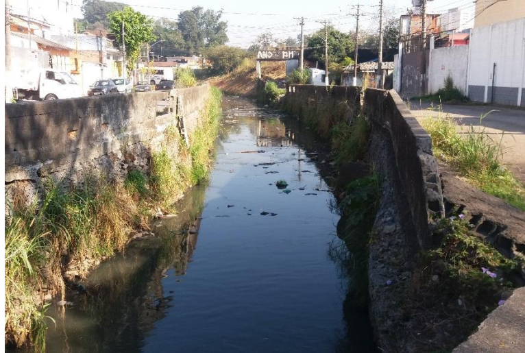
Figura 19 – Transição entre a Seção 02 (retangular com gabião) e a Seção 01 (trapezoidal, em estado natural), ao fundo.
